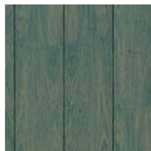
Doghe verticali fugate
